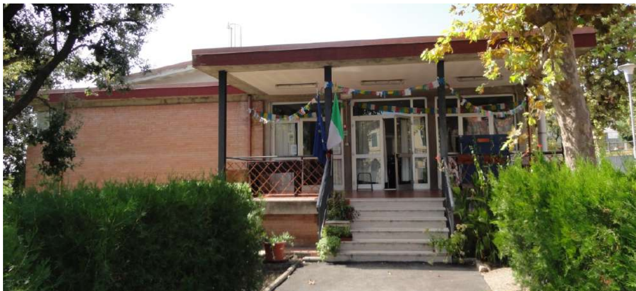
Figura: loggia d'ingresso con colonne in profili di acciaio
