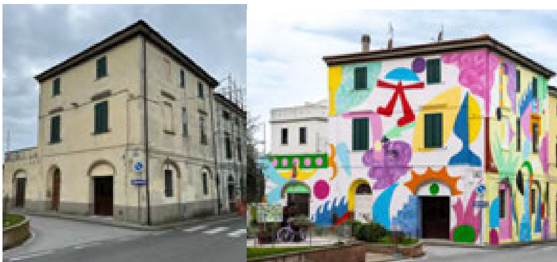
FOTO Piazza Baldasserini prima e dopo l’intervento
