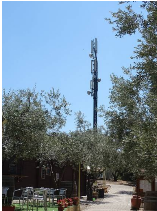
Foto 1: Vista d'insieme degli impianti TIM, Vodafone e Wind Tre - foto del 10/07/2017
